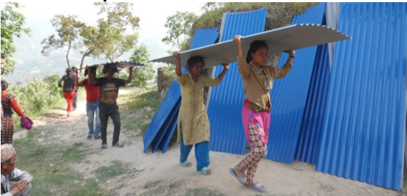
Wellblechdächer für neue Unterkünfte
